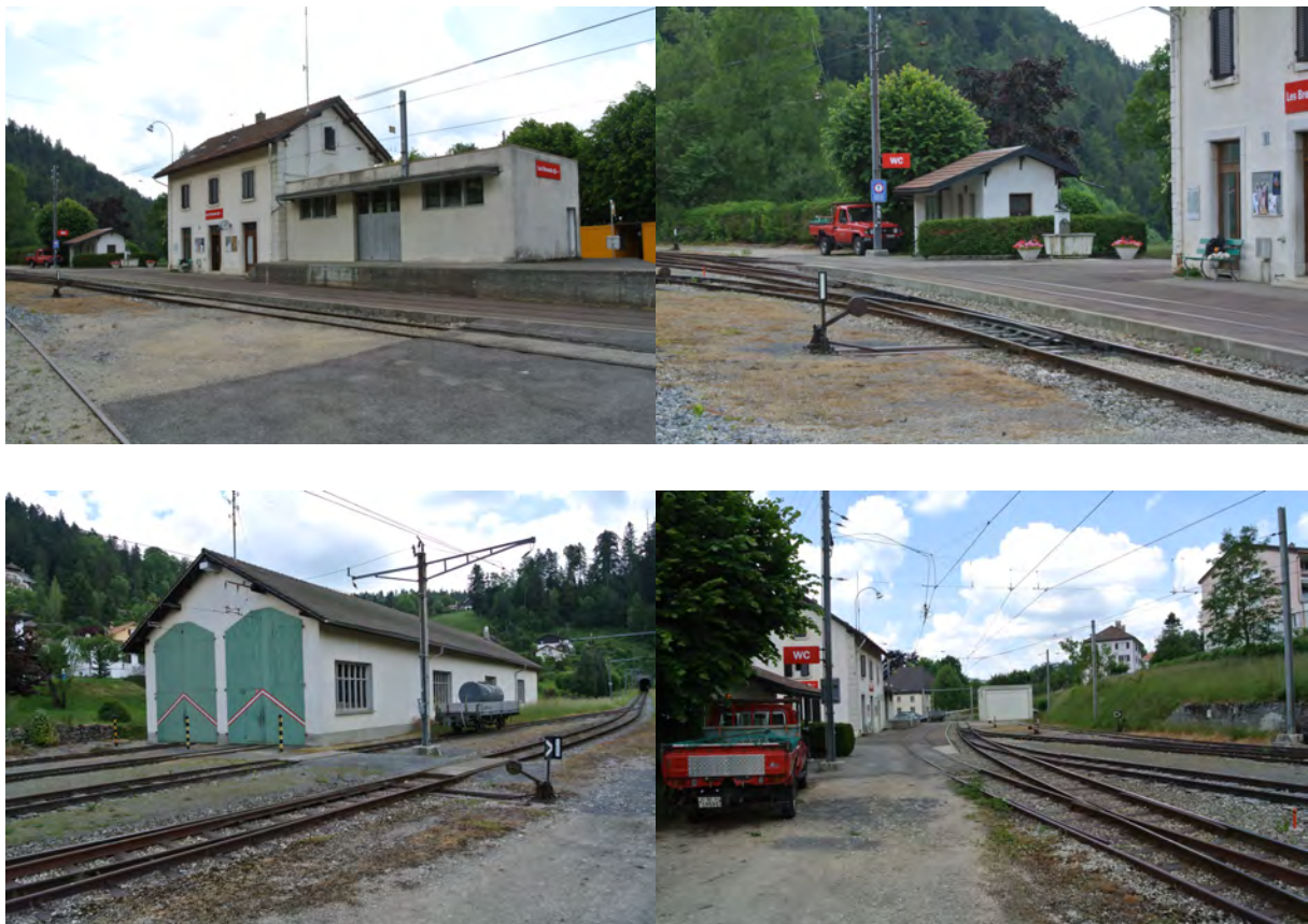
Fig. 16: Images de la gare des Brenets avec les différents bâtiments
