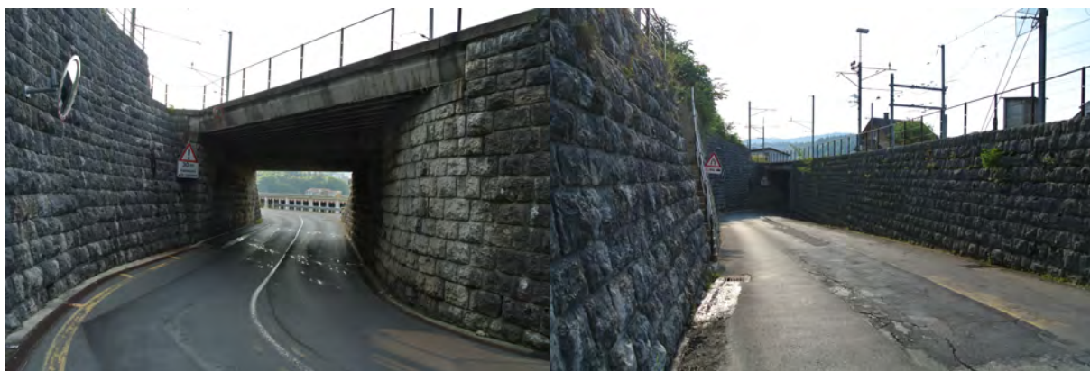
Fig. 41: Pont ferroviaire qui surplombe la rue de la Côte
